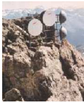
Se ubican en lugares difíciles
